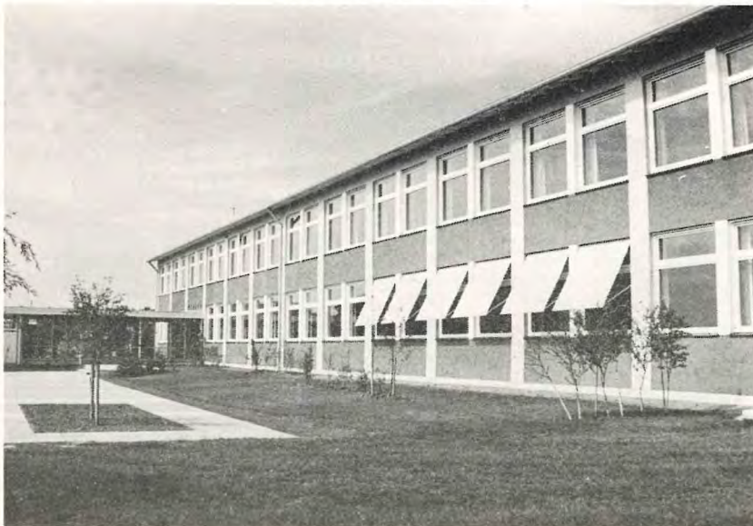
Westseite mit Schulhof
