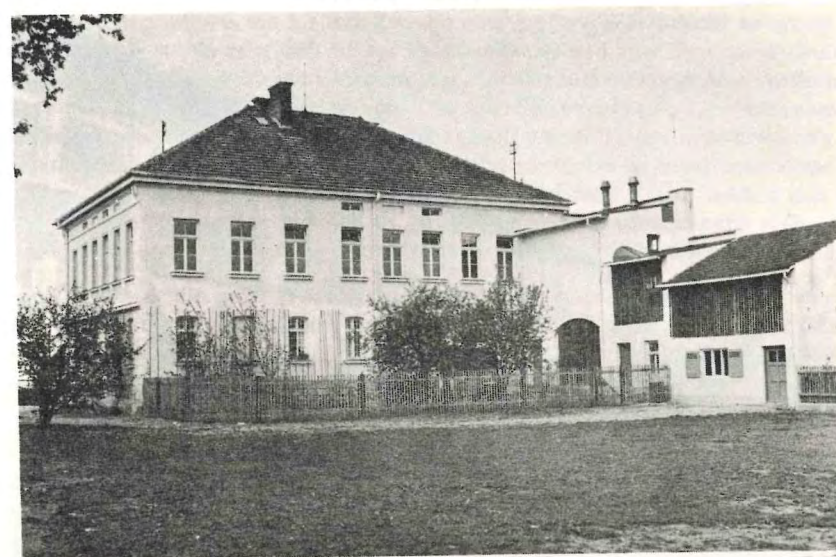
Das 1893 erbaute alte Schulhaus von Osten gesehen
